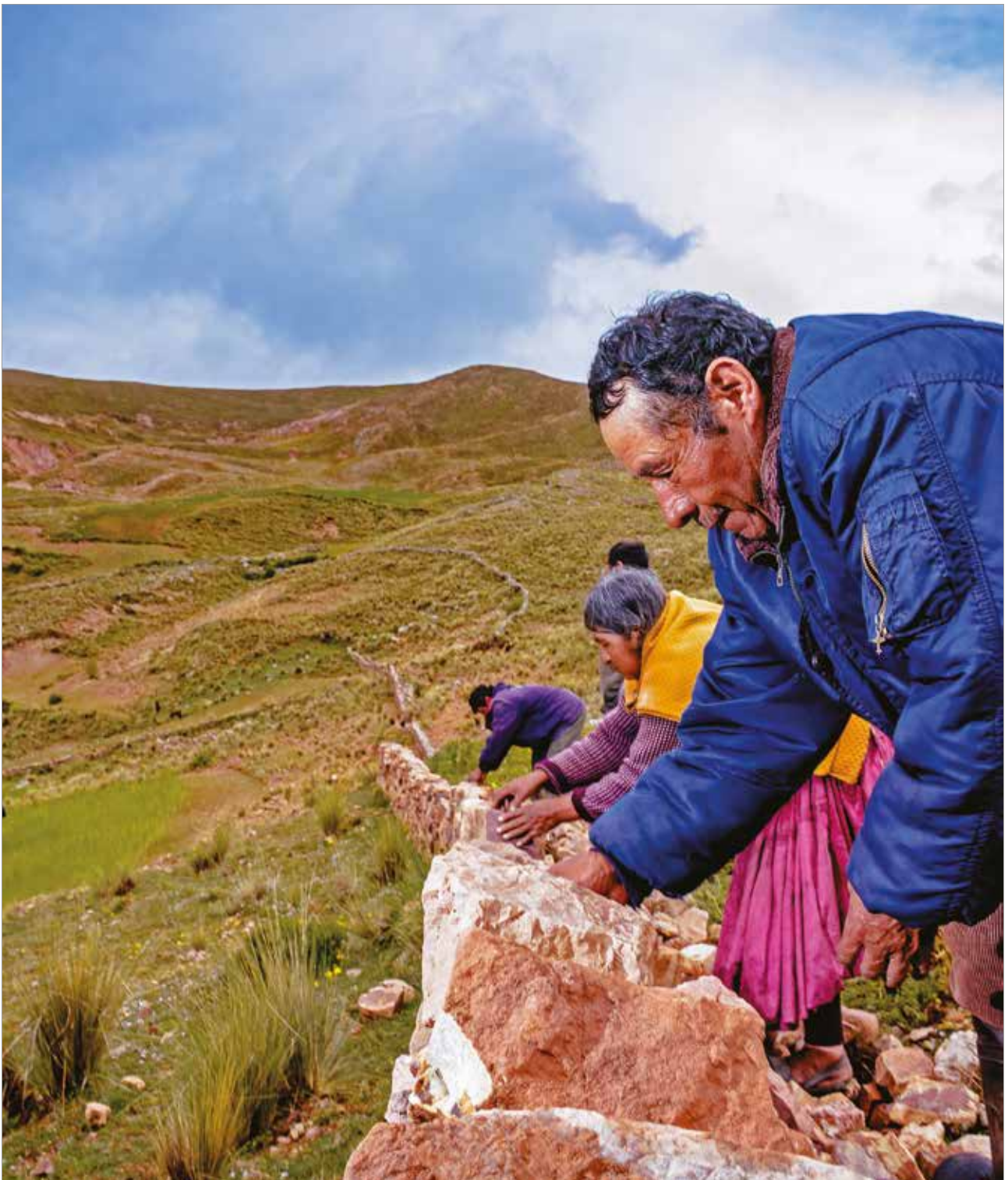
Esquencachi, la comunidad levanta muros de piedra. Potosí.
